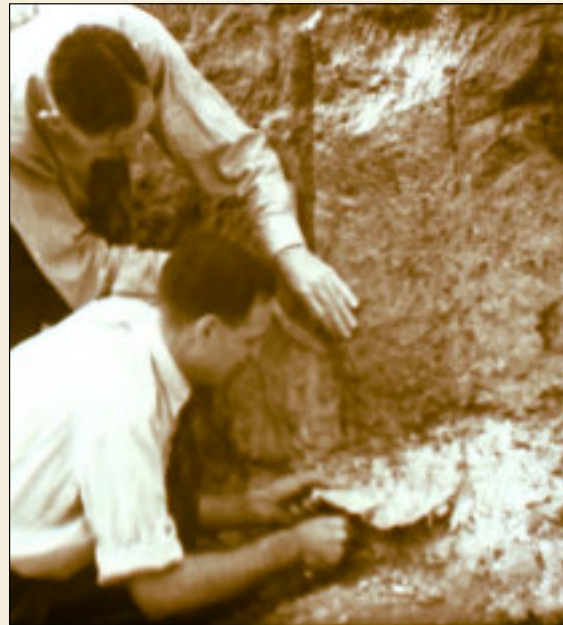
Dr. Voigt (im Hintergrund) und ein Mitarbeiter in den 1930-er Jahren bei der Abnahme eines Bodenprofils mit der Lackfilmmethode.
