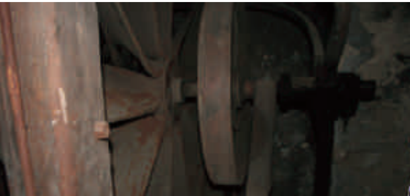
Abb. Blackman Ventilator in situ (Foto P. Westphalen).
