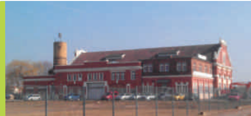
Abb. Ehemaliges Elektrizitätswerk in Dresden-Cossebaude (Foto W. Wünschmann)
