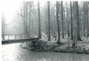
Die «Laura-Brücke» über die Röder. Jetziger Zustand
